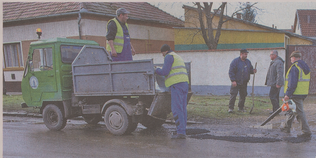
A közmunkások a kátyúzásoknál is közreműködnének a jövőben
